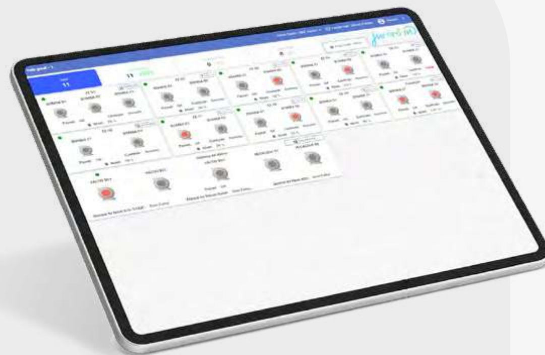
Monitoramento em tempo real do sistema de telemetria das elevatórias de esgoto.
